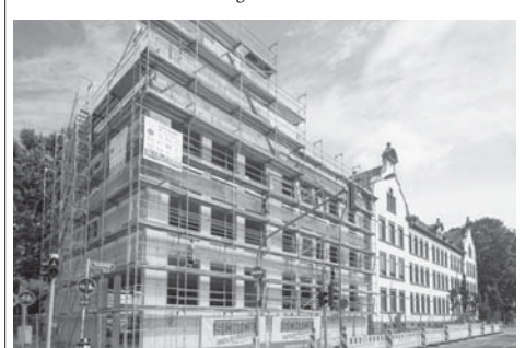
Die denkmalgeschützte Hostatoschule in Höchst wird zurzeit umgebaut. Doch die Bauarbeiten verzögern sich. Archivfoto: Varnhorn
