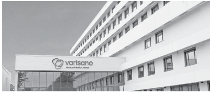
Das neue Klinikgebäude ist das weltweit erste mit Passivhauszertifikat.
